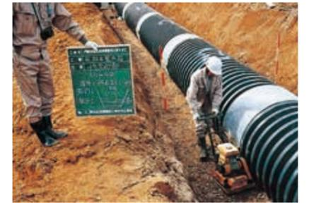
裏込めにあたっては、偏圧がかからないように管の両側の裏込め高さが常に同じになるようにし、各層毎にランマー等で十分に締固めしてください。
