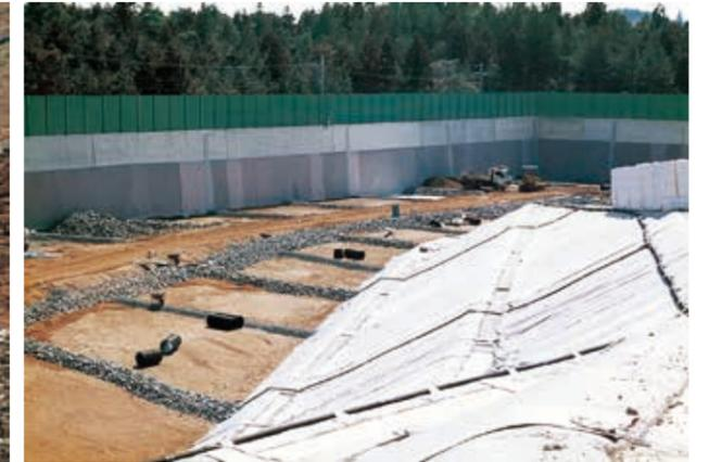
一般廃棄物処理場浸出集排水・ガス抜き管工事
