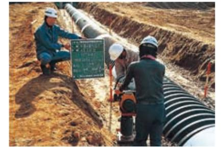
管上30cmまでは20cm~30cmごとに埋戻し材を入れランマー等で十分締固めしてください。
